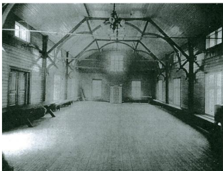
Figur 4. Nye Fabrikksalen ombygd fra 1909-1910.
